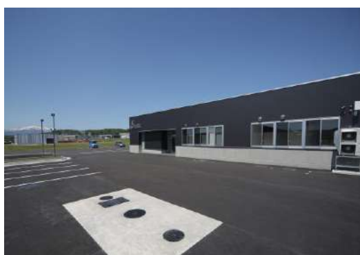
2020年5月稼働の新工場(山形県)
