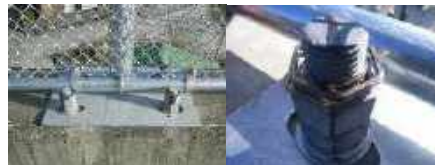
&lt;高速道路安全柵取付け工事&gt;
