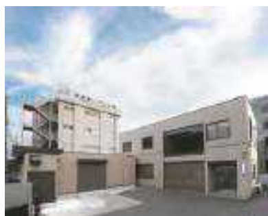
本社・本社別棟
