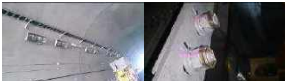
&lt;高速道路トンネル照明取付け工事&gt;
