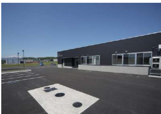
2020年5月稼働の新工場(山形県)
