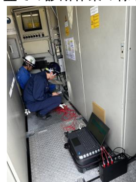
動力制御盤での診断作業の様子
