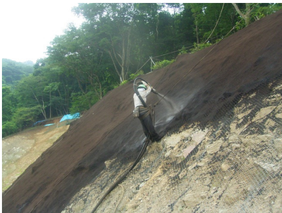
急峻な斜面への緑化基盤材の吹付工事
