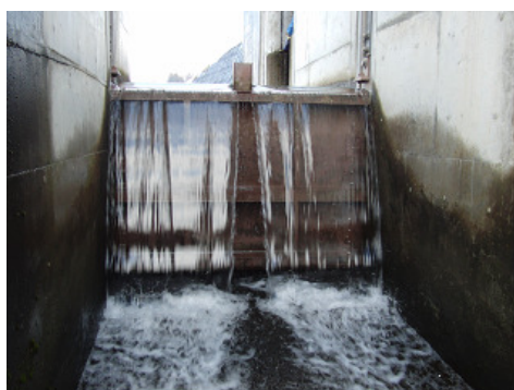
図1 既設の水門における水膜振動
