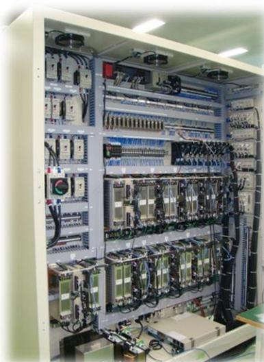
装置制御盤Assy
